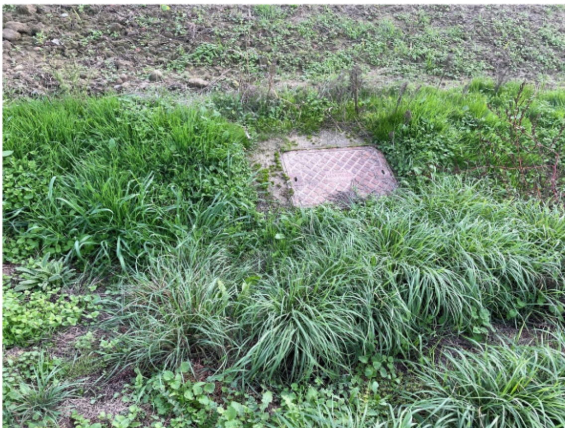
FIGURA 6-5 INTERFERENZA 4 - POZZETTO DI ISPEZIONE DELLA TUBAZIONE DI SCARICO DELLE ACQUE BIANCHE DELLA CASCINA SAN MICHELE CON TOMBINO IN GHISA
